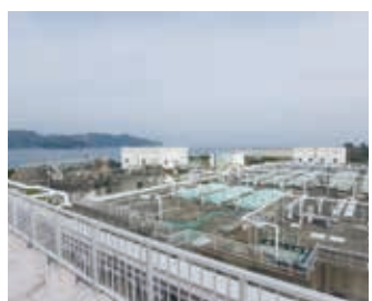
岡郷にある長与浄化センター。町内の汚水は全てここに集まります。
