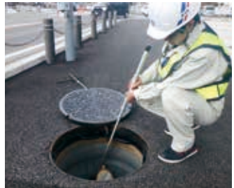
下水道管やマンホールの点検・調査の様子です。
