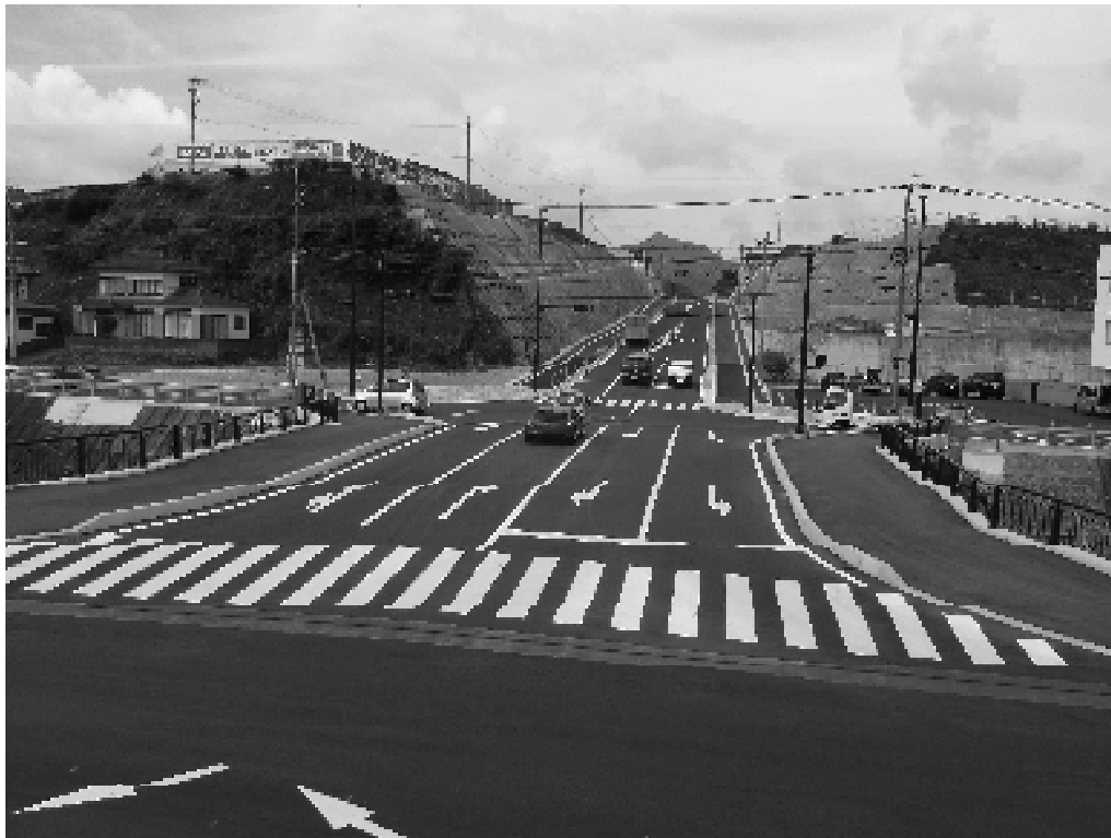
(起点側（長与中央橋）から終点側を望む)
