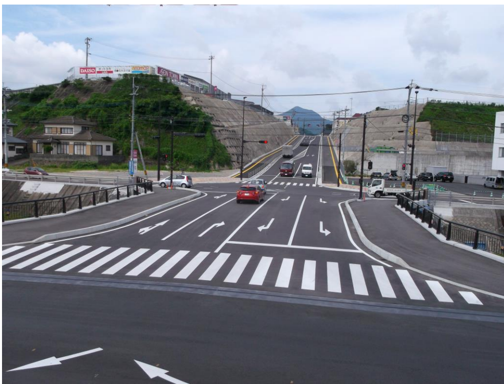
起点側（長与中央橋）から終点側を望む
