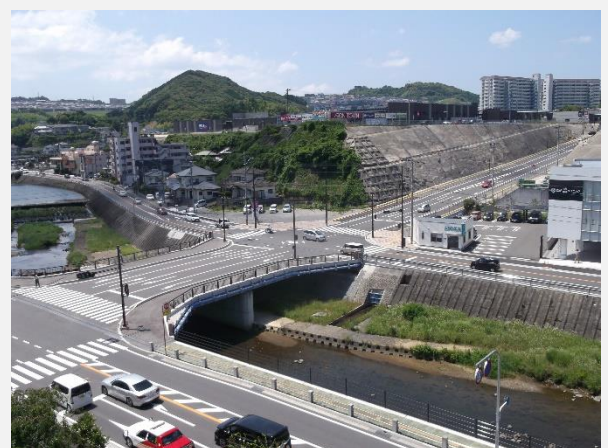
■都市計画道路西高田線の新設区間
