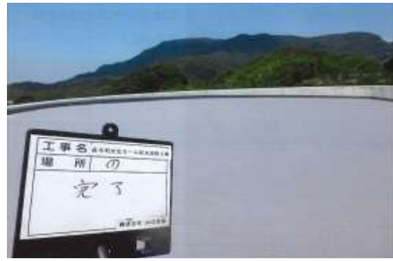
【改修後】5階屋上
