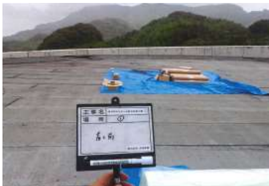
【改修前】5階屋上
