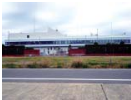
下水処理を行う浄化センター
