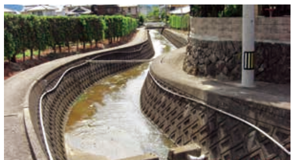
両岸と川底をコンクリートで固める三面張り工法
