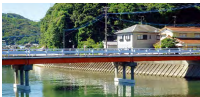
補修工事が終わった新浦橋
