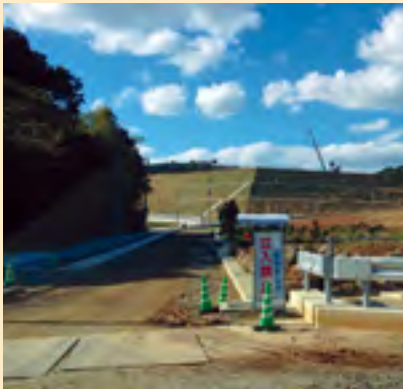
焼却施設につながる道路
