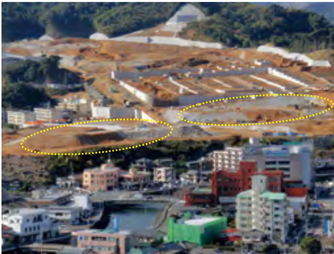
工事が進む榎の鼻地区 左が商業用地 右が公益用地
