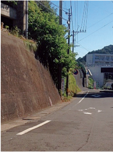
ガードパイプが設置されます
