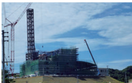
工事が進む熱回収施設
