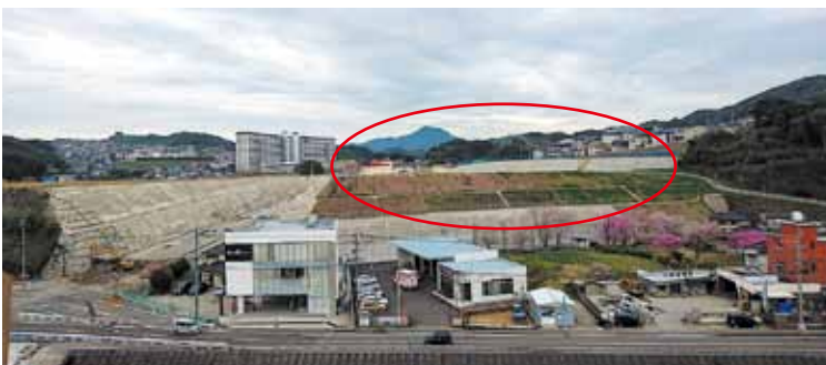
役場正面高台へ…新図書館建設予定地
