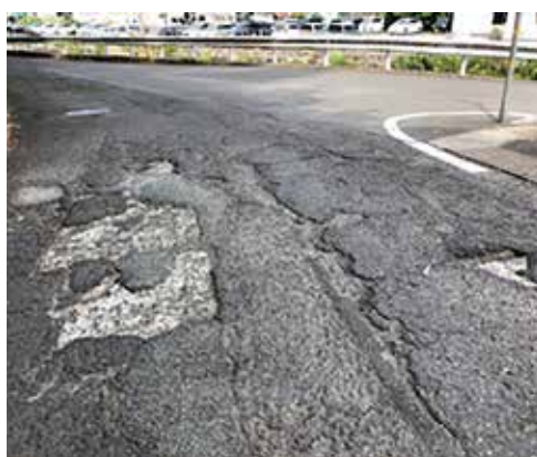
急いで 道路改修
