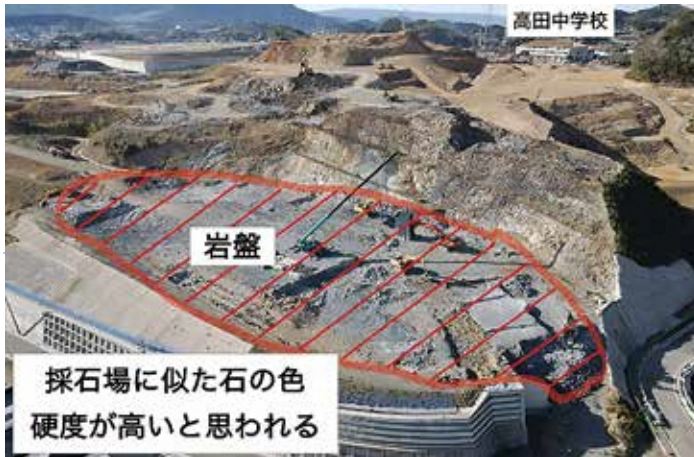
高田南土地区画整理事業の中での岩盤掘削を望む
