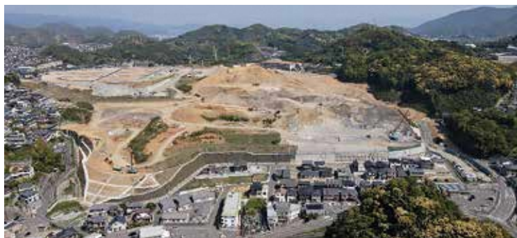
一部宅地が完成 周辺道路の供用も一部開始
