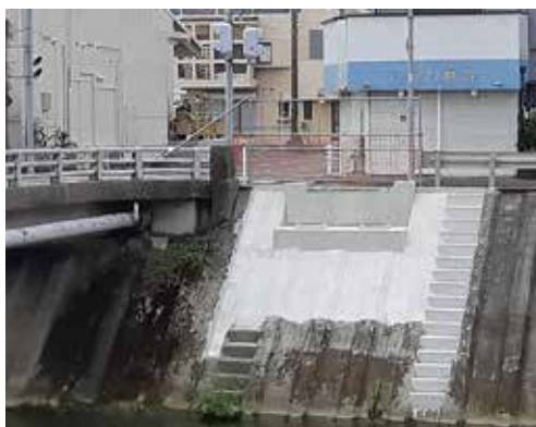
定林橋側道橋下部工工事（県道側）
