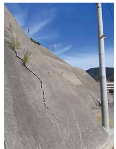
大丈夫？のり面のひび割れ
