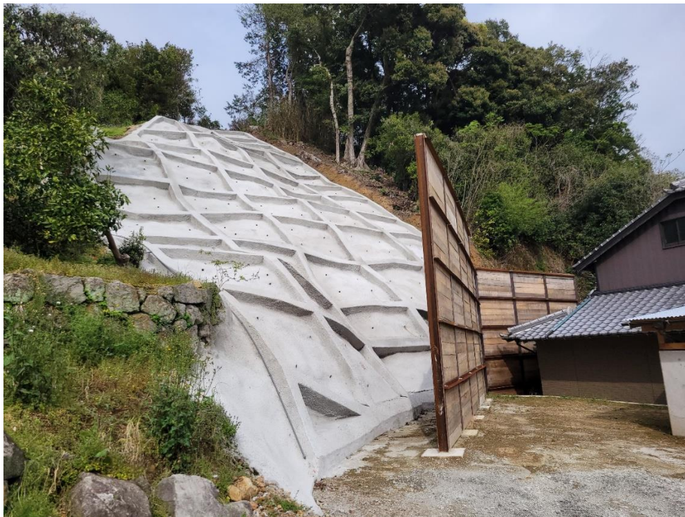
(古園地区急傾斜地崩壊対策工事 施工後)
