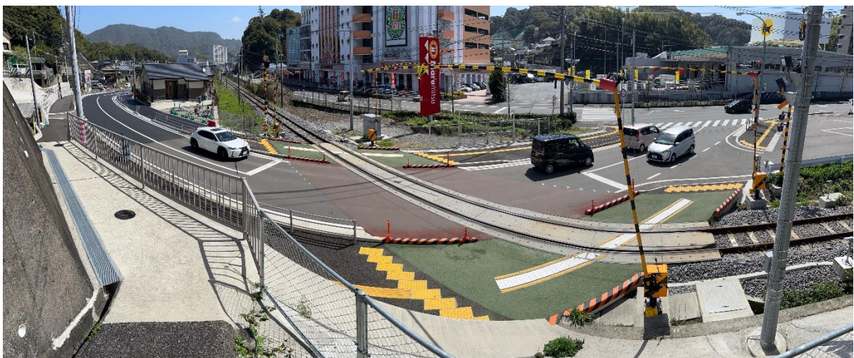
（改良後の JR 高田踏切付近）
