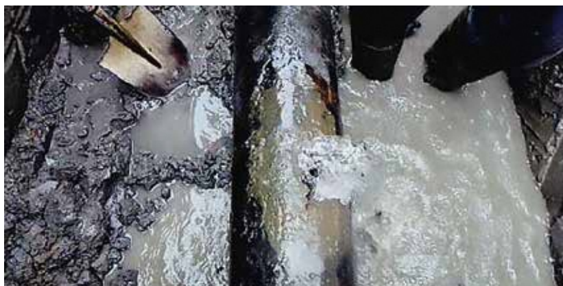
老朽化で破損した本町の配水管（岡郷・平成30年）
