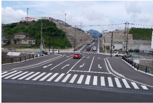
中心地に接続する長与中央橋
