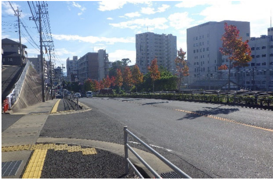
長崎市へ接続する主要地方道長崎多良見線
