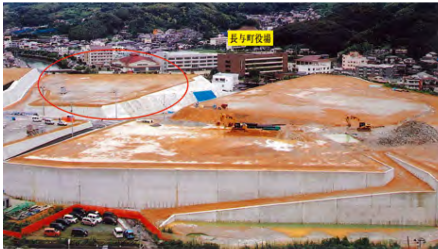
新図書館建設予定地
