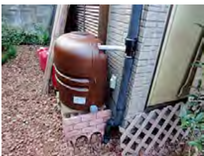
雨どいとつなぎ、雨水をためるタンク
