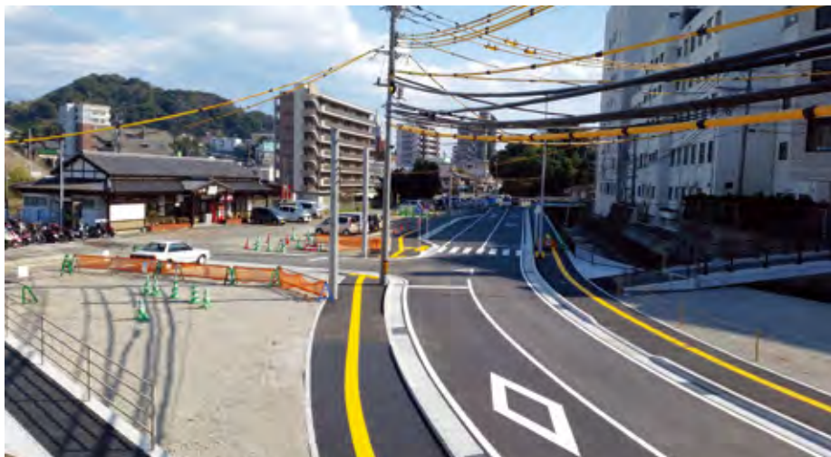
整備が進む道ノ尾駅周辺
