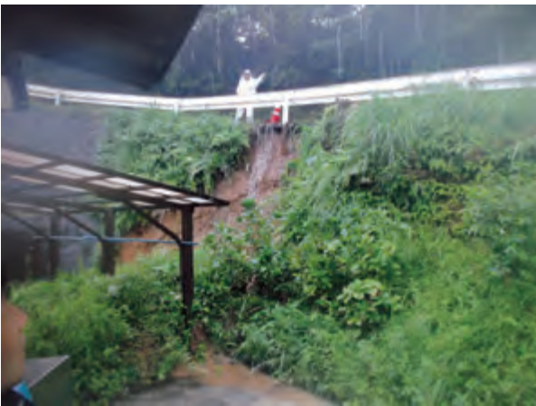
忠魂碑線 被災状況
