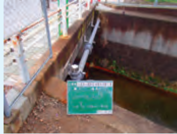
配水管敷設工事
