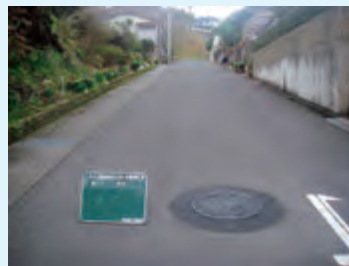
下水道改良工事
