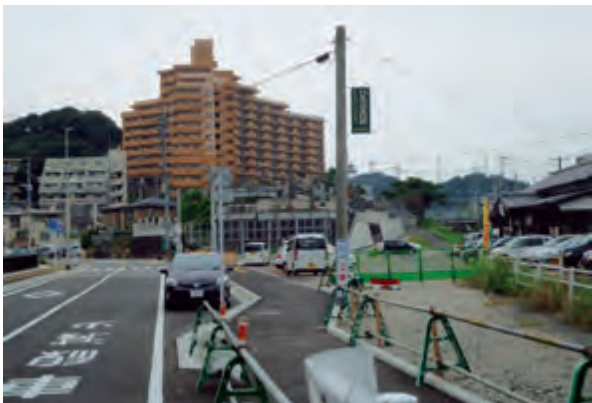
もう少しで改良工事が終了予定の道ノ尾駅前
