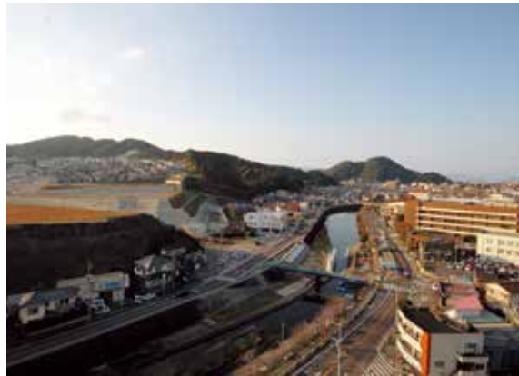
造成が進む榎の鼻土地区画整理地
