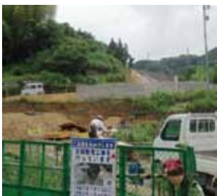
擁壁工事が進む道の尾地区
