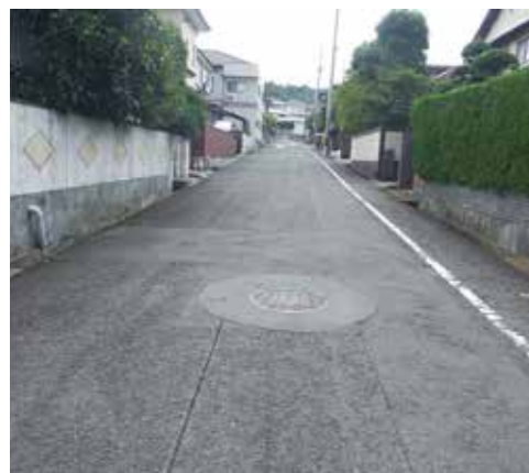
青葉台マンホール蓋改築工事
