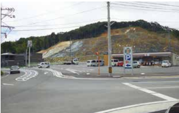
三千隠線切土工事（浦上水源池側より）
