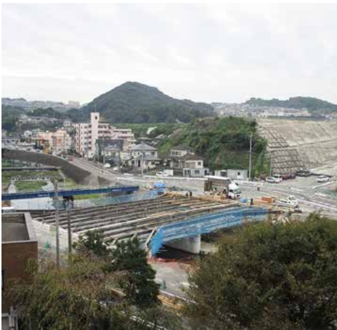
工事の進む役場横架橋
