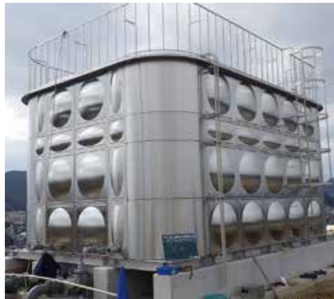
道ノ尾配水池築造工事
