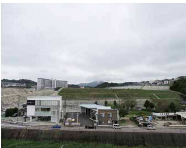
放置されたままの、図書館建設予定地
