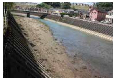
測量の結果 県より撤去不要とされた土砂の堆積状況
