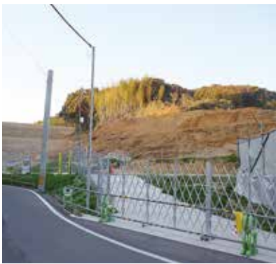
擁壁工事が進む
