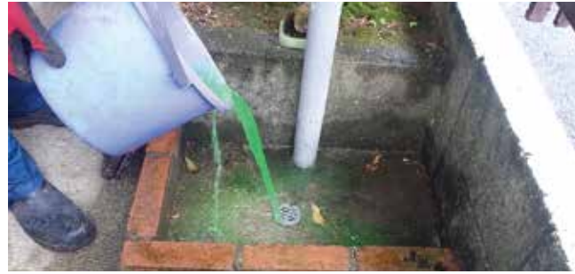
色水を流しての不明水調査
