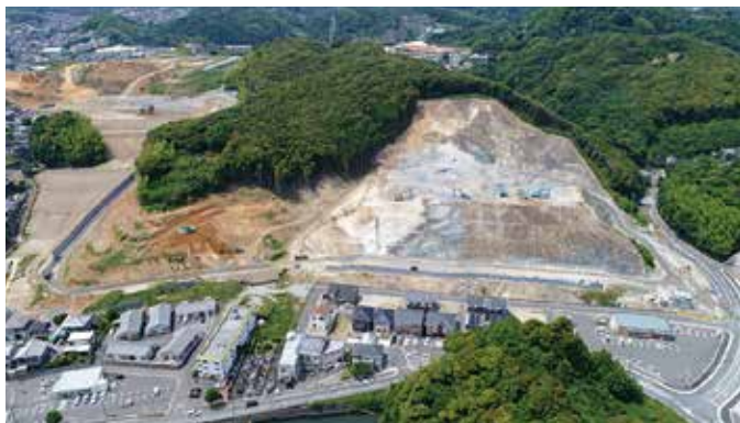
早期完成を（浦上水源池付近）
