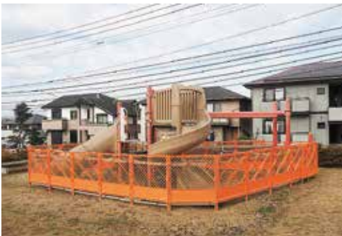
使用禁止となった遊具 早期の復旧を
