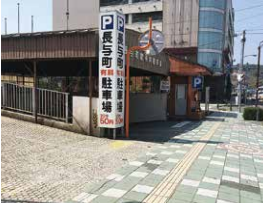
修繕予定の嬉里駐車場
