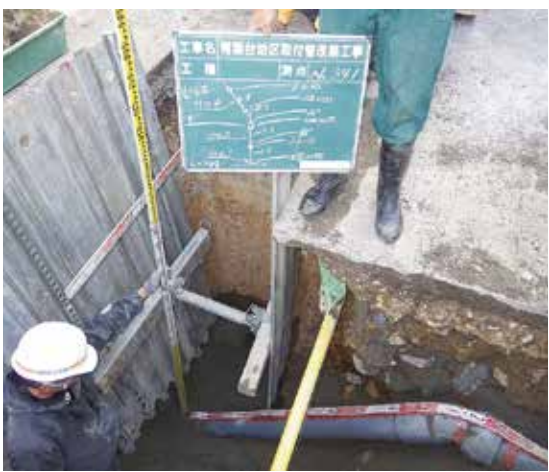
古い污水管取り替え中（青葉台地区）
