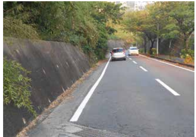
商業高校グラウンド横長崎市道 北側法面
