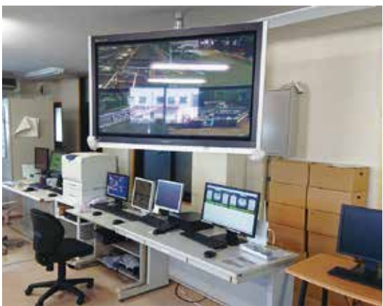
大型モニターで水道施設を監視します (水道施設統合監視システム導入)
