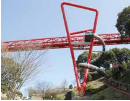
長与町のシンボルとなるか スパイルスライダー
