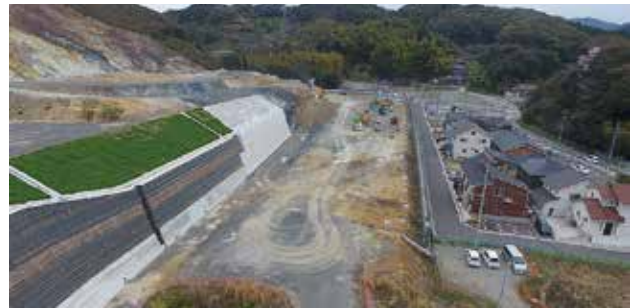
工事が続く高田南
