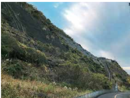
樹木が繁茂 危なくないの？早期の対策を（ニュータウンの切取法面）
