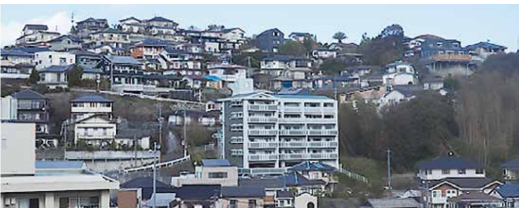
簡易水道は上水道に統合（自由が丘団地）
