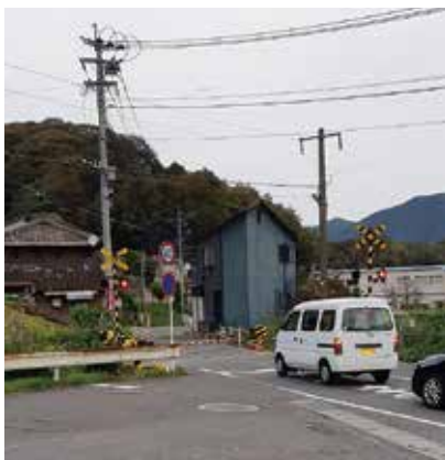
改修予定の高田踏切
