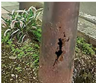
街路灯根元の腐食した穴
