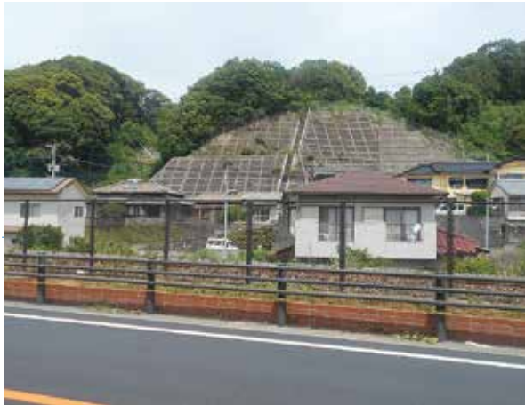
急傾斜地崩壊対策事業により保護された山の斜面 (西高田地区)
