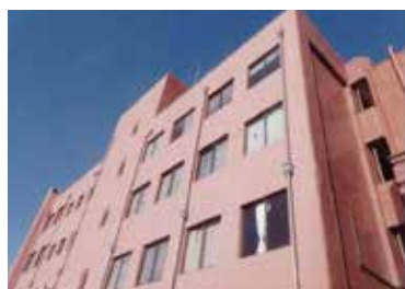
▲勤労青少年ホーム 外壁改修 (令和元年度)
