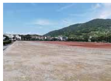
▲運動公園広場トラック改修 (令和2年度)
