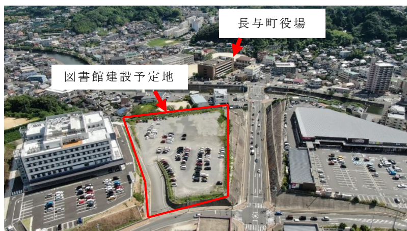
ドローンによる空撮写真
