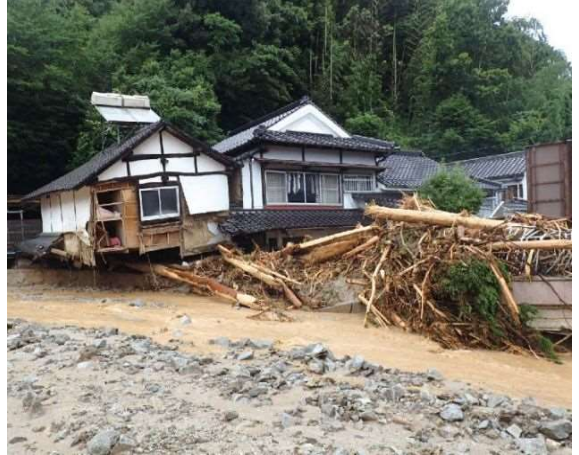
写真：家屋被害と流木（福岡県朝倉市）
