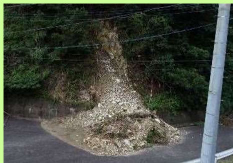
写真：令和2年7月豪雨で発生したがけ崩れ（時津町）
