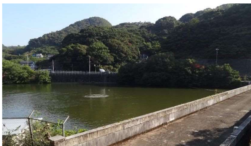
写真 浦上ダム曝気状況（長崎市）
