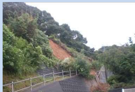
写真：令和3年8月豪雨で発生した がけ崩れ（長与町）
