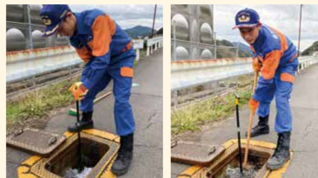
↑ 地域の消防水利(消火栓)の点検を行う山口分団員 消防団は消防水利や地域の危険箇所の点検も行います!
