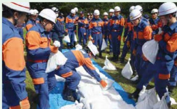
7月7日、台風シーズンを前に、町内での水災害を防ぐための技術の習得を目的として、水防工法訓練を行いました。団員は長崎市北消防署浜田出張所職員の指導を受けながら、初めに重さ約20kgの土のうを作成しました。続いて、被害が発生した状況を想定し、3段積み土のう工法、改良積み土のう工法、月の輪工法の手順や使用する資機材の取り扱い方法を確認し、実際に土のうを積み上げました。参加した団員は、真剣に指導を聞き技術を学びました。
