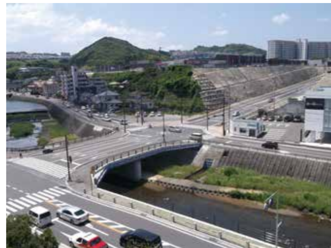
都市計画道路西高田線の新設区間
