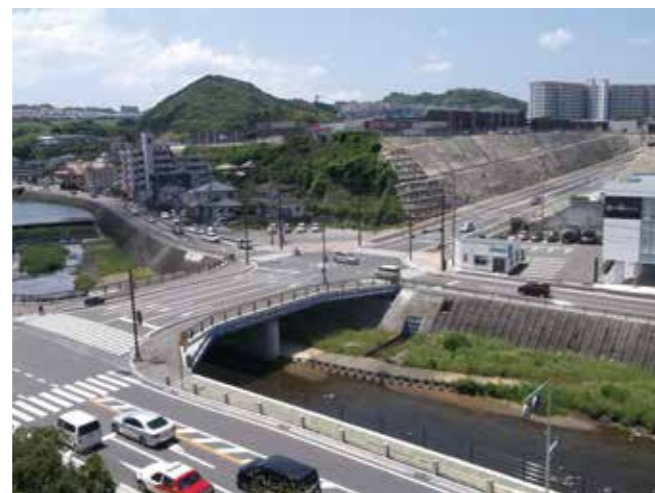
都市計画道路西高田線の新設区間
