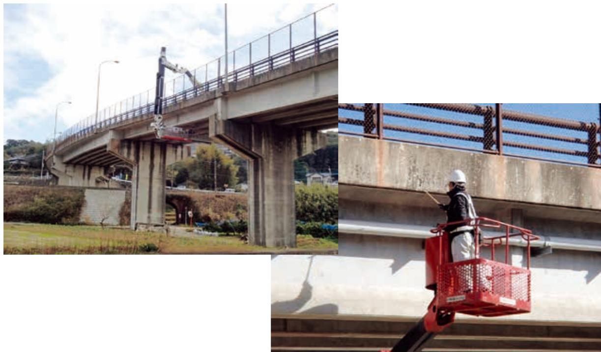
橋梁点検状況（三根大橋）
