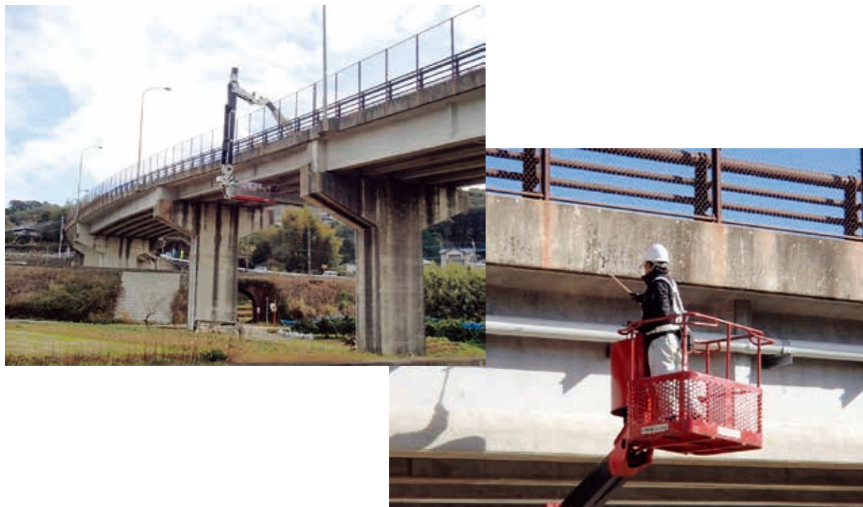
橋梁点検状況（三根大橋）
