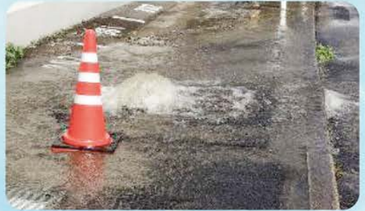
破損した水道管からの漏水
