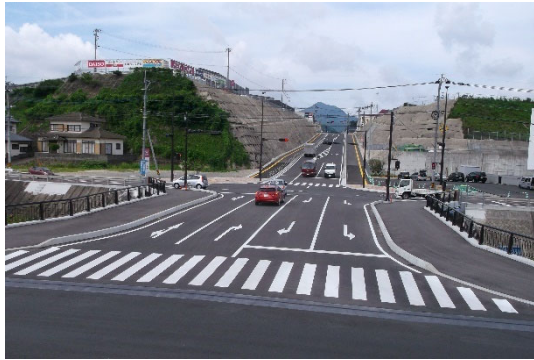
中心地に接続する長与中央橋
