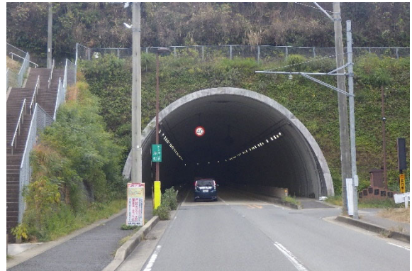
高田越トンネル
