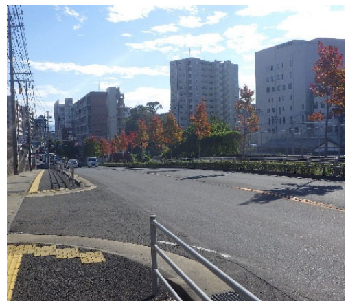
長崎市へ接続する主要地方道長崎多良見線
