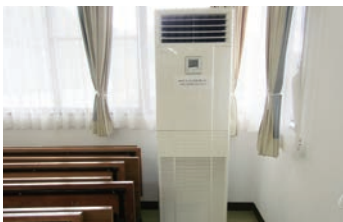
▲働く婦人の家 空調機設置工事
