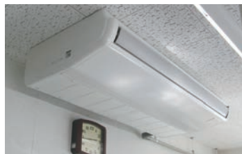
▲上長与地区公民館 空調機設置工事
