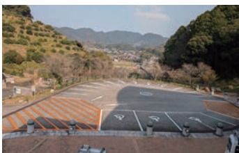
▲長与町民文化ホール駐車場区画線工事
