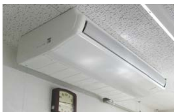
▲上長与地区公民館 空調機設置工事
