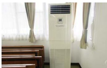
▲働く婦人の家 空調機設置工事
