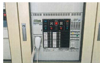
▲長与町民文化ホール 非常放送設備及び複合火災受信機更新工事
