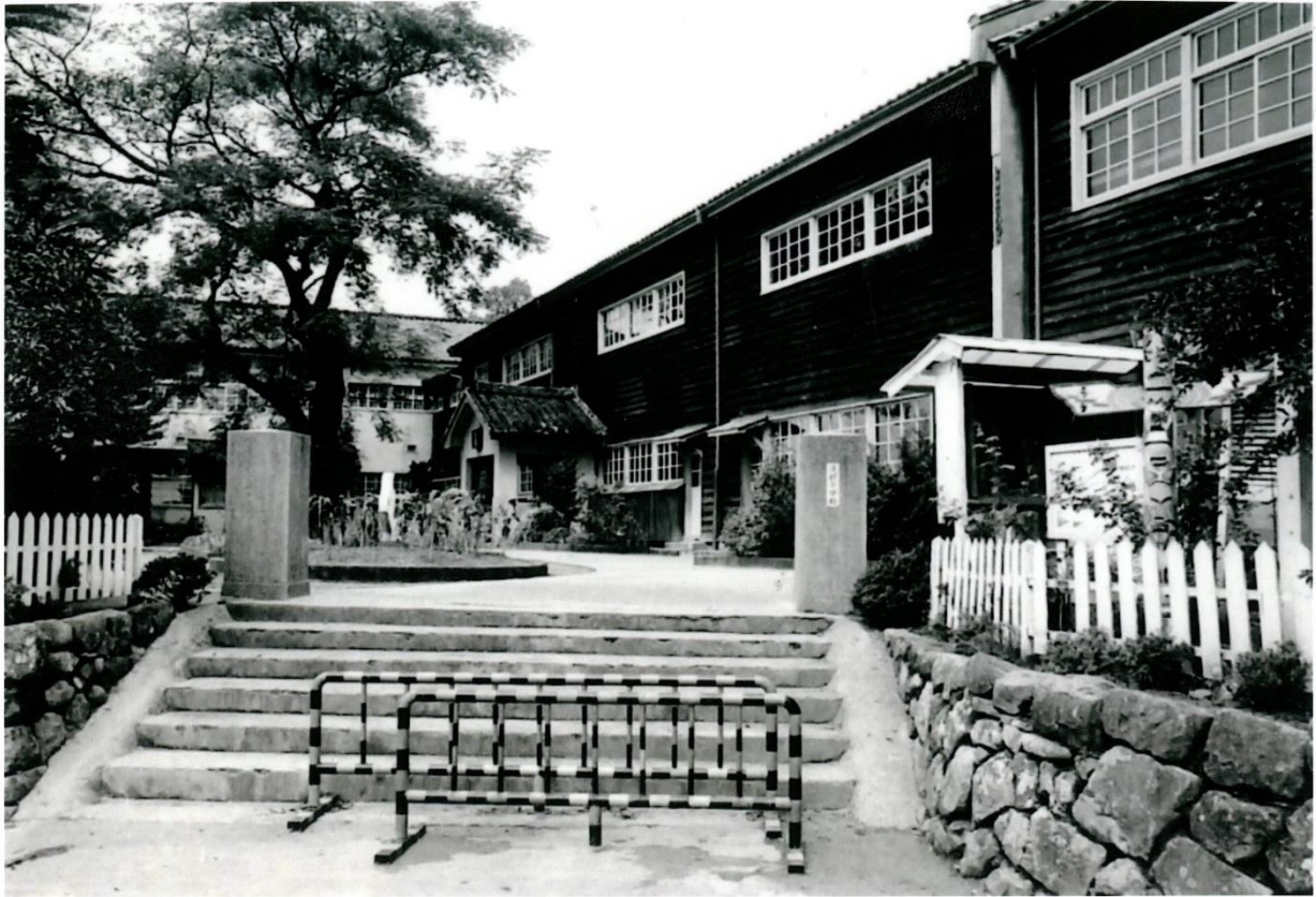
洗切小学校 昭和40(1965)年
