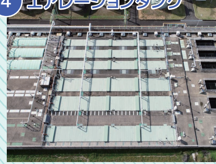
4 エアレーションタンク
