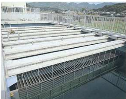
【傾斜板沈殿池】
