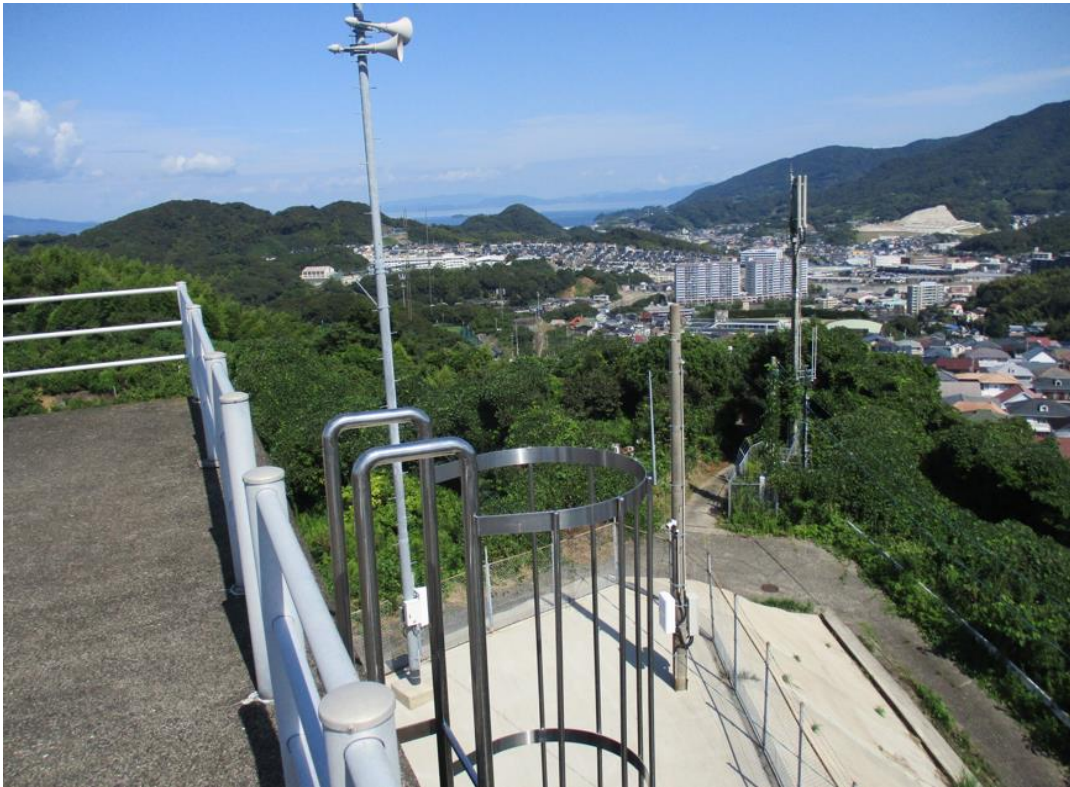
南陽台高部配水池より
