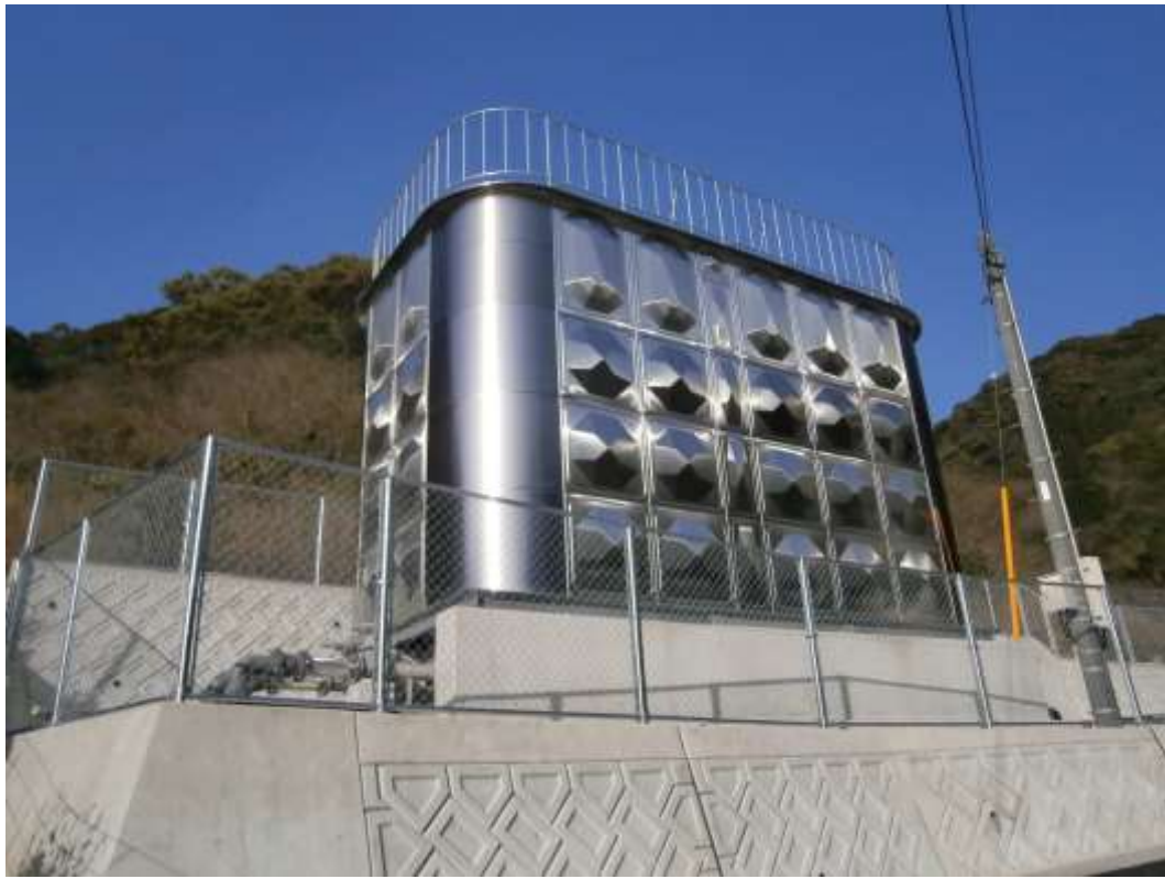
新平木場配水池（令和3年3月竣工）
